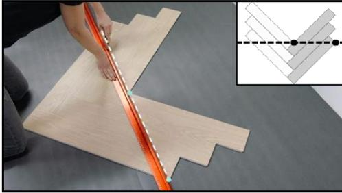
1. Ziehen Sie auf der Dekorseite der Platten eine gerade Linie von der rechten Ecke der zuletzt verlegten R-Planke (dritte R-Planke) (Nr. 6) zum oberen Mittelpunkt des Dreiecks. Ziehen Sie die Linie durch.
