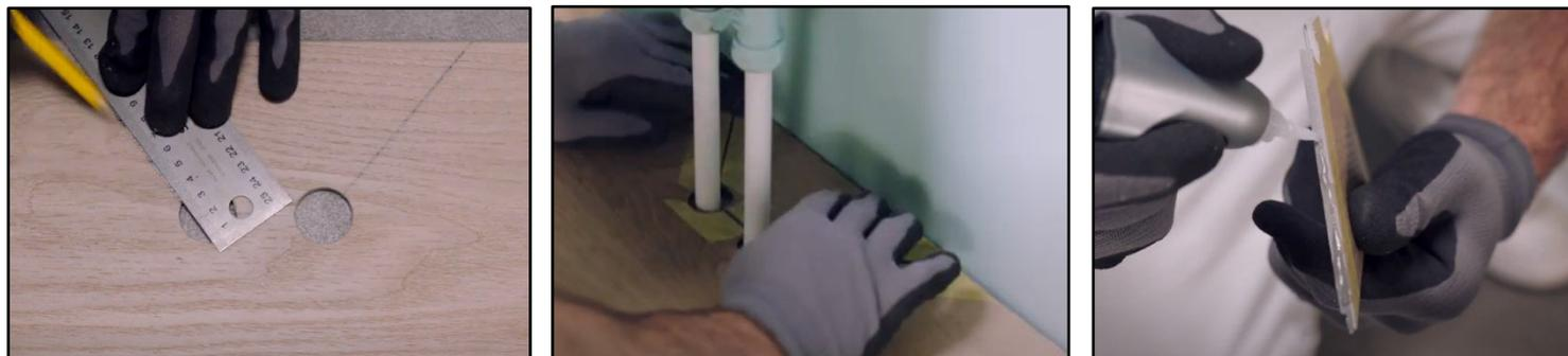
Bei einem Doppelrohr bohren Sie an allen markierten Stellen ein Loch mit demselben Durchmesser wie die Rohre, wobei Sie 15 mm abzählen. Wenn sich die Rohre an der Längsseite der Fliese befinden, machen Sie einen 45-Grad-Schnitt von jedem Loch zur Seite der Fliese.
