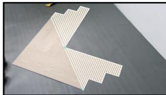
***Bei Bedarf können Sie es auch mit einem Teppichmesser schneiden. Legen Sie dazu die Planke mit der Dekorseite nach oben. Verwenden Sie zum Schneiden mit dem Teppichmesser eine Latte oder eine andere Planke. Gehen Sie mindestens 2 bis 3 Mal über das zu schneidende Teil. Drehen Sie die Planke um und gehen Sie auf der Schnittlinie in die Hocke. Ist das abzuschneidende Stück der Planke zu klein? Dann eine Zange als Hebel benutzen.***
