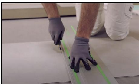
7. Tracez la distance mesurée sur une nouvelle dalle entière en partant du bord supérieur (décor) sur le petit côté où se trouve la languette. N'incluez pas la languette. Maintenant, à l'aide d'une latte et d'un cutter, coupez 2 à 3 fois sur le dessus de la dalle. Tournez ensuite la dalle avec le côté décoratif vers le bas et cassez-la facilement
