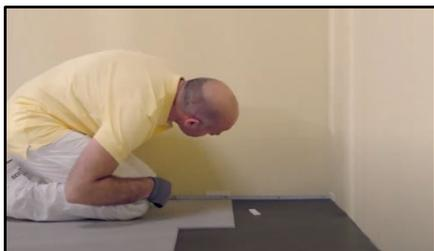
6. La dernière dalle incomplète de la première rangée doit maintenant être placée. Pour ce faire, mesurez la distance entre le bord supérieur (décor) du côté court de la dernière dalle entière et une cale de 5 mm, qui a été placée contre le mur. Attention! Veillez à ne pas commencer à mesurer à partir de la rainure, mais plutôt à partir du bord supérieur de la dalle.
