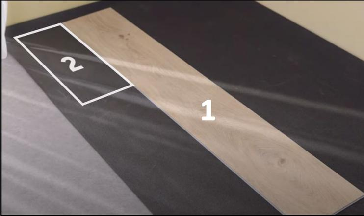
1. Beginnen Sie mit der ersten, vollständigen Planke (Nr. 1), das sich in der linken oberen Ecke des Raumes befindet. Verlegen Sie die beiden Seiten vorzugsweise mit der Feder zu den Wänden und achten Sie darauf, dass die Dehnungsfuge von 5 mm eingehalten wird. Die Nut oder Feder ist nicht Teil der Dehnungsfuge. Schneiden Sie sie nötigenfalls ab.
