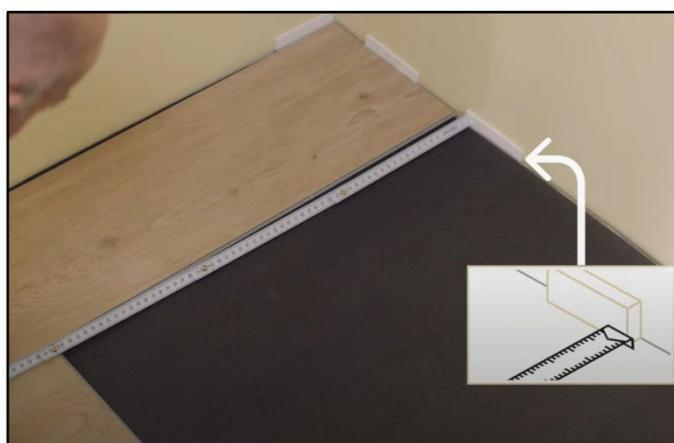
7. À partir de la troisième rangée, placez les planches rangée par rangée. Veillez à placer suffisamment de cales dans les joints de dilatation pour que le sol ne se déplace pas. Utilisez un mélange varié de décors et de planches provenant de différents paquets.
